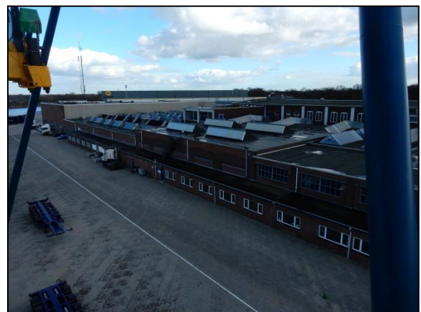
Figuur 7. Foto vanuit de kraan, westelijk terreindeel.
