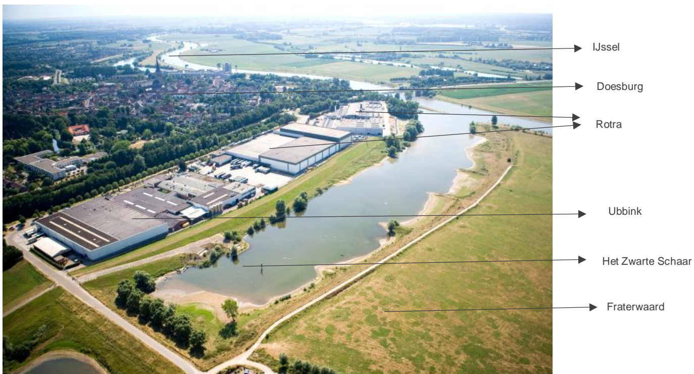
Figuur 1.1 Overzicht van het bestaande bedrijventerrein aan de Verhuellweg in Doesburg
