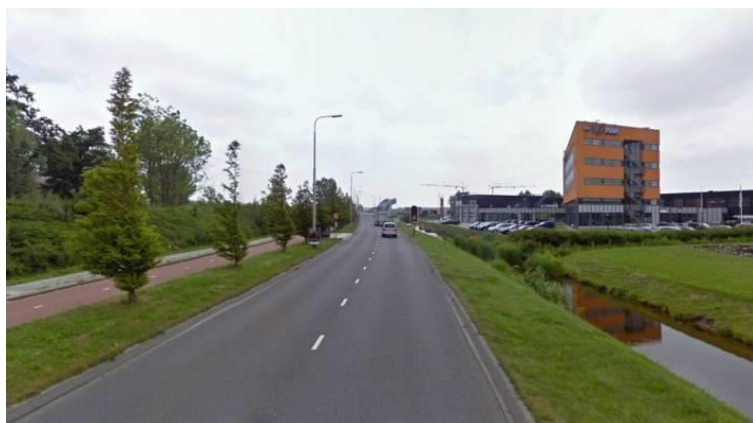
Slauerhoffweg (gebiedsontsluitingsweg met vrijliggend fietspad)
