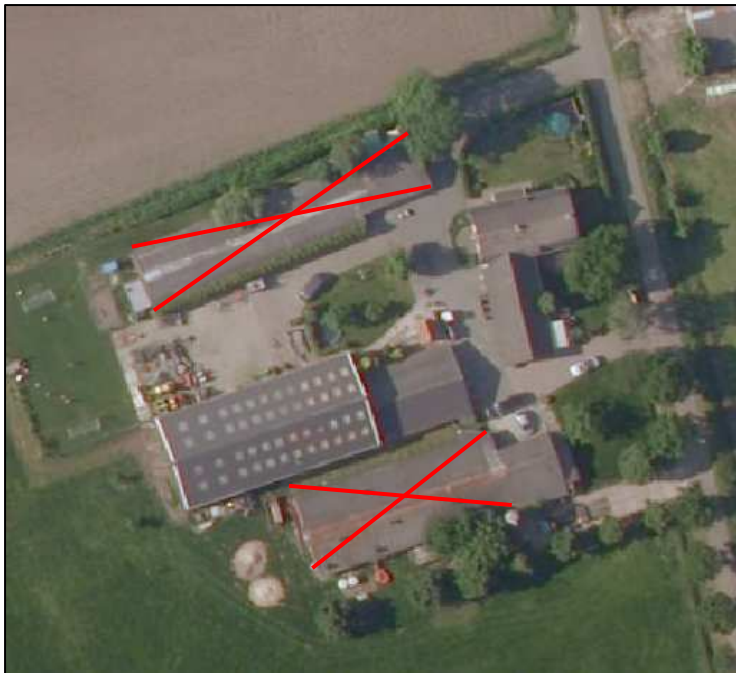
Figuur 8: Beeld van de te slopen bebouwing aan Groesbaan 2
