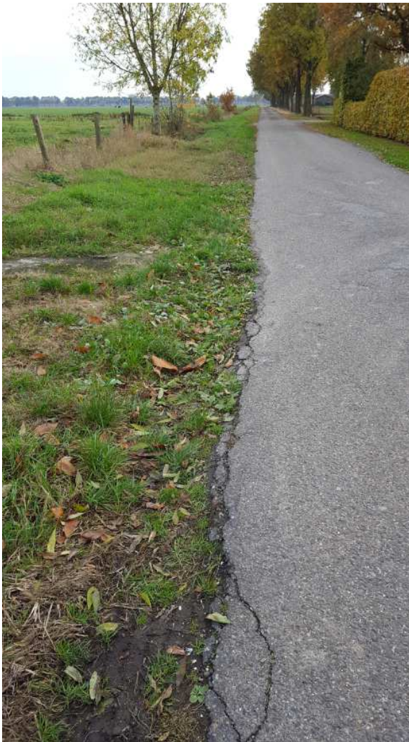
Figuur 11: Beschadiging wegdek voor achteruit inparkeren van zware wagens voor mengvoer voor de varkens (links) en de inrit van het bedrijf (rechts)
