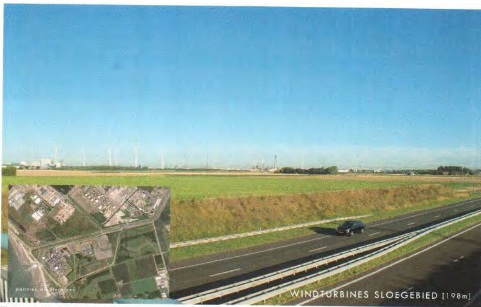
Figuur 4.15. Beeld vanaf het viaduct van de Mosterweg over de N62
