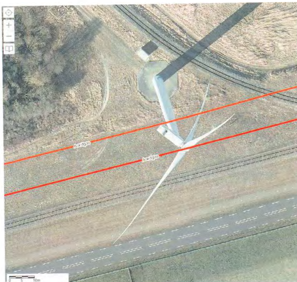
Figuur 2.3. Windturbine EPZ (tiphoogte 123m) op 15m afstand van de aardgasleiding. Bron Geoweb Zeeland, luchtfoto 2015.
