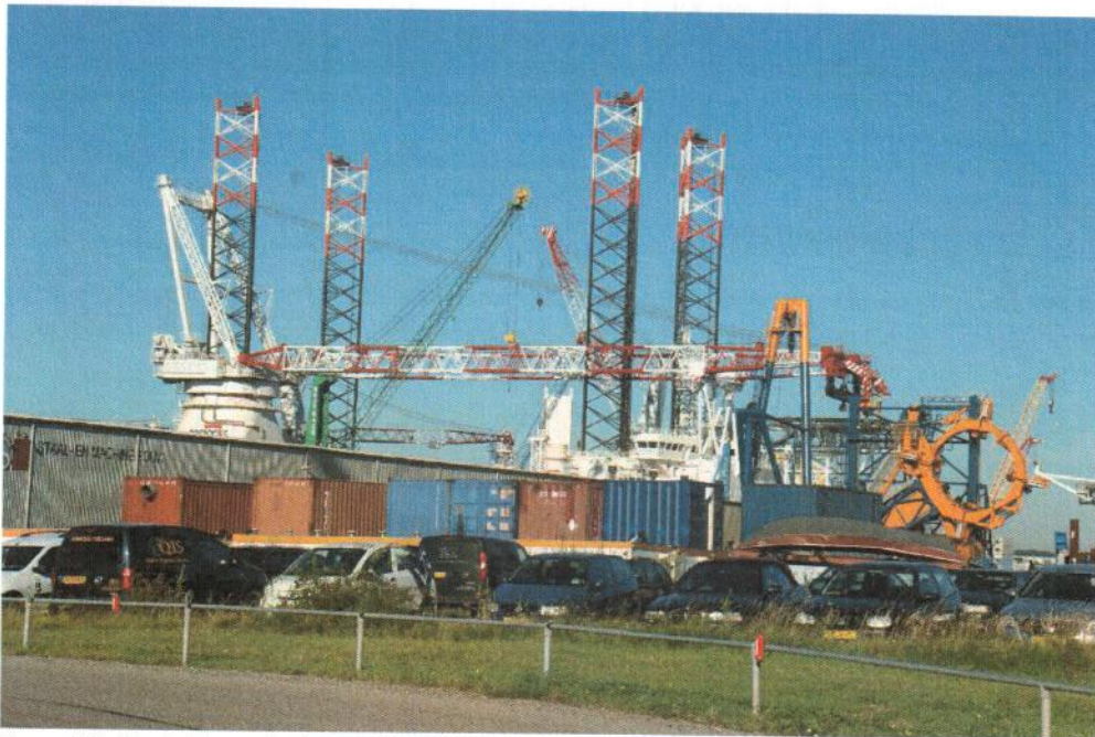
Figuur 1.5. Werkschepen in de haven, met poten en kranen met een aanzienlijke hoogte
