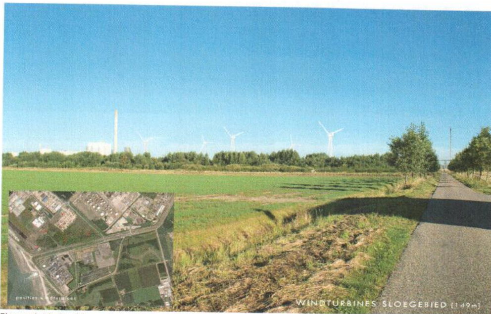
Figuur 4.11. Beeld vanaf de Weelweg ter hoogte van de woning Eben Haëzer. De afstand tot de schoorsteen is 1.350m. Windturbines met een tiphoogte van 149 meter
