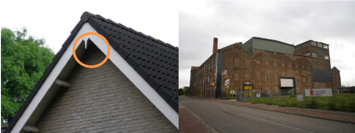
Foto 3: Links: woning aan de Achterdijk. Onder de dakrand zijn uitwerpselen van vogels waargenomen (binnen oranje cirkel). Rechts: bebouwing op het industrieterrein heeft potentie voor broedende vogels.
