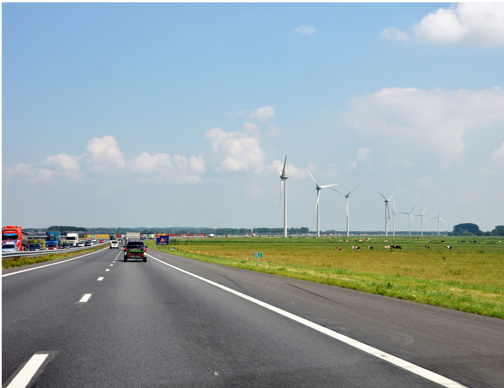
Windturbines bij Echteld (ashoogte 78m, rotordiameter 82m) en bij Buren (ashoogte 105m, rotordiameter 90m)
