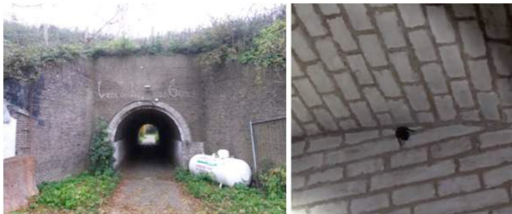
Figuur 2.5 Foto(s) entree fort en locatie overwintering vleermuizen.
