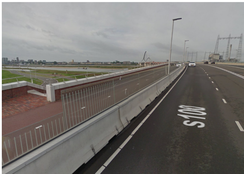
Het bestaande scherm op de Oversteek
