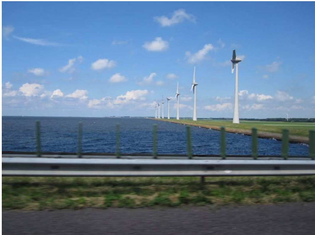
Zicht vanaf A6 op de Ketelbrug
