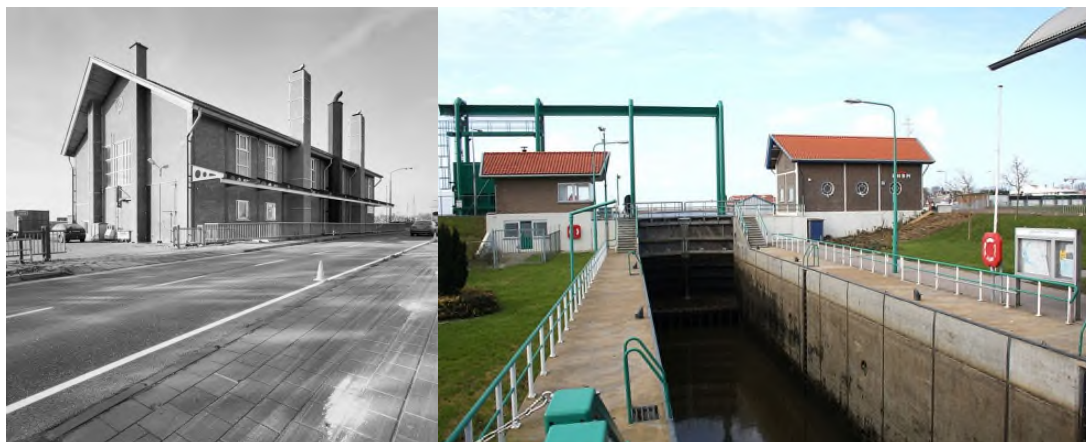
Figuur 4.27 Links: Gemaal Visserink, rechts: Sluiswachtershuisje, Schotbalkenloods en Urkersluis
