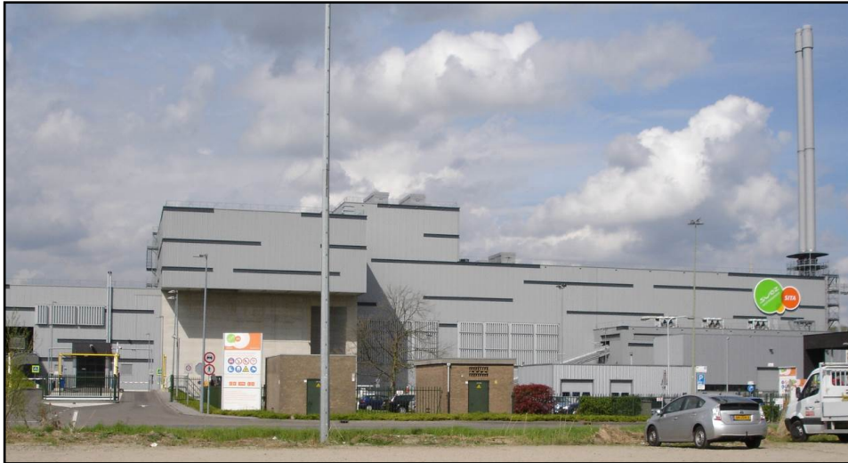
Figuur 1.1 : projectlocatie op de voorgrond en erachter de afvalenergiecentrale van SITA
