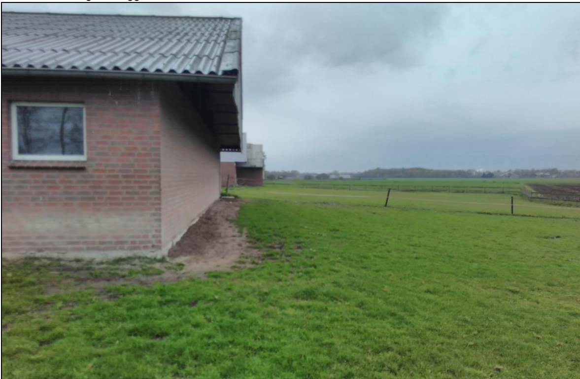
foto "uitbreiding tbv biggenstal":
