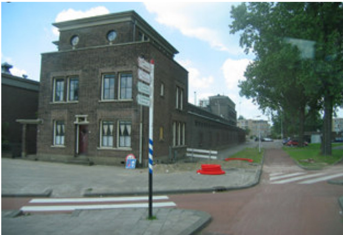
Figuur 3.22: RET-kantoor Sluisjesdijk [Haskoning 2005]
