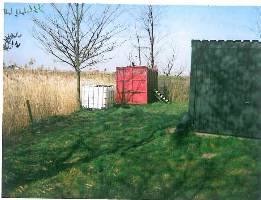
Uiterste zuidwesthoek van de locatie met dieselaggregaat gezien in westelijke richting.
