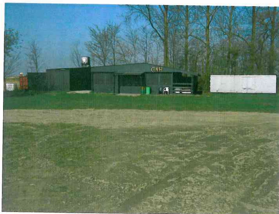
Clubgebouw met op voorgrond parkeerterrein gezien in westelijke richting.
