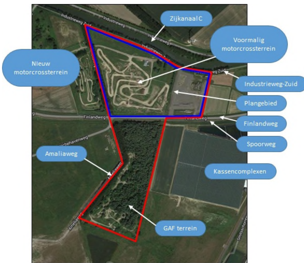
Afbeelding 1.1: Gebied waarop van het voorziene afvalverwerkingsbedrijf Beelen worden onderzocht (Bron: Google-maps), blauw omlind het bestemmingsplangebied, rood omlind het plangebied van het MER
