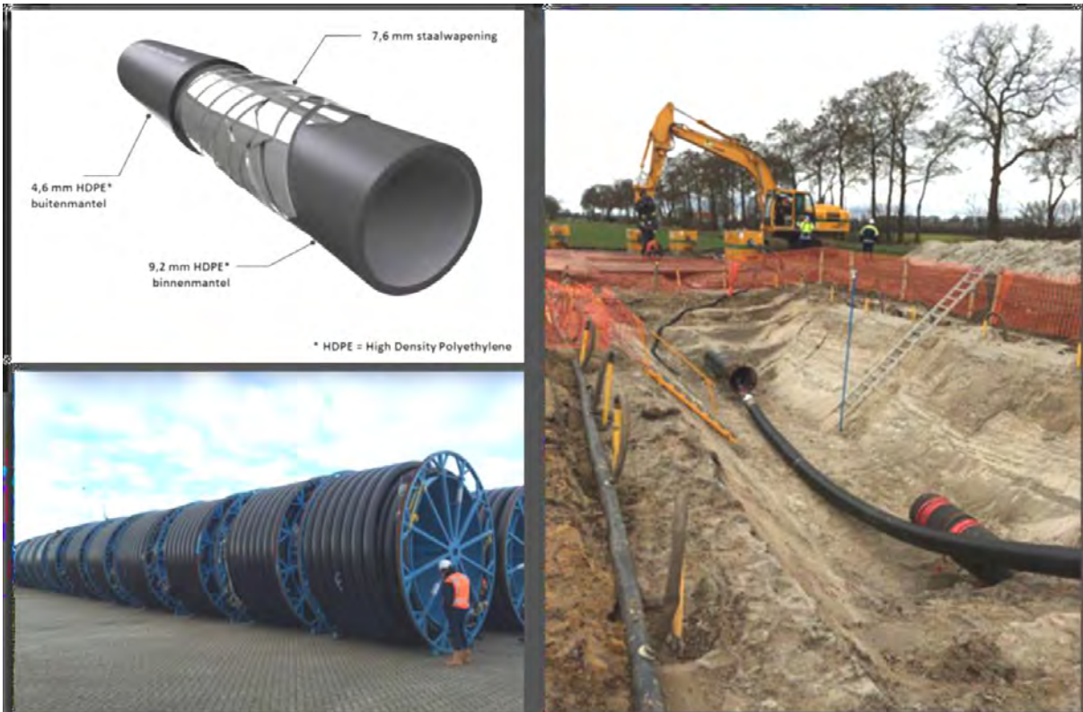
Figuur 4.9: Pijp in pijp aanpassing van transportleiding.
