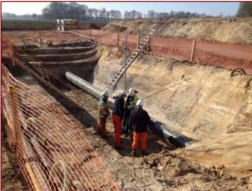
Figuur 4.8: Sanering lekkage bij de transportleiding.
