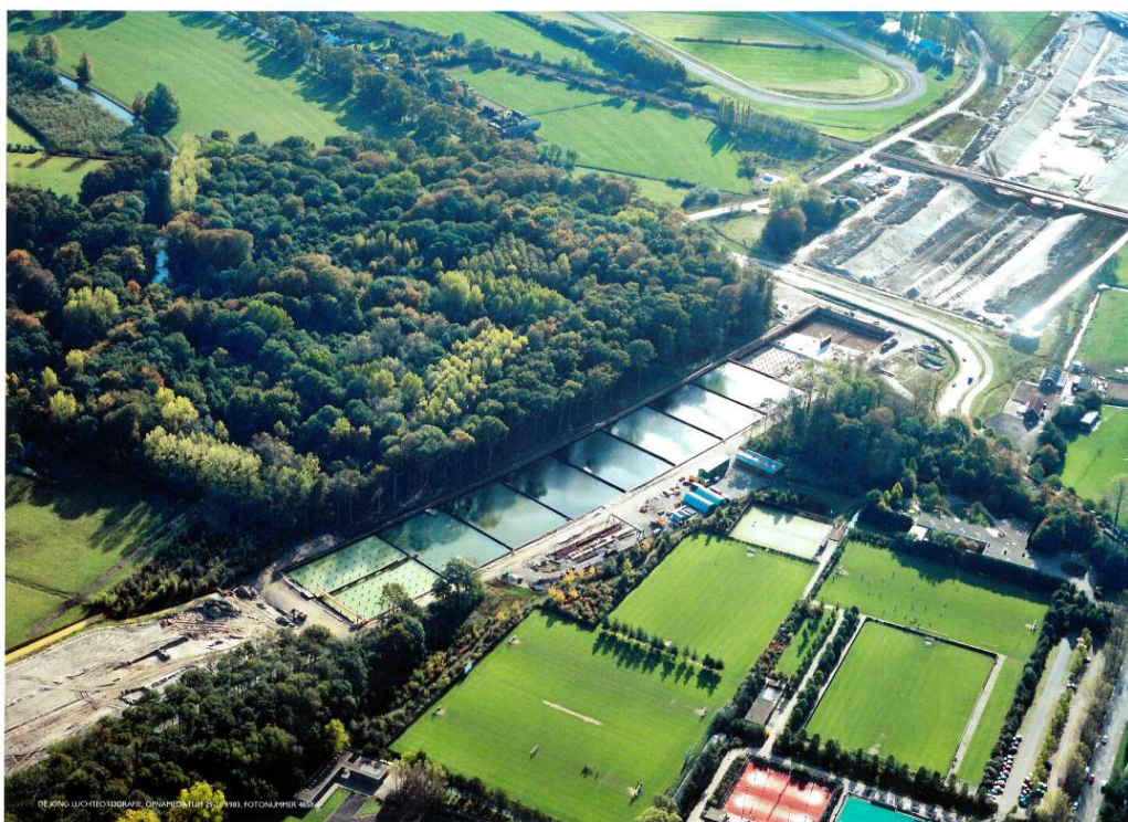
Figuur 5.7 Luchtfoto aanleg tunnelbak en folieconstructie A27, periode 1983-1985 (bron: RWS)
