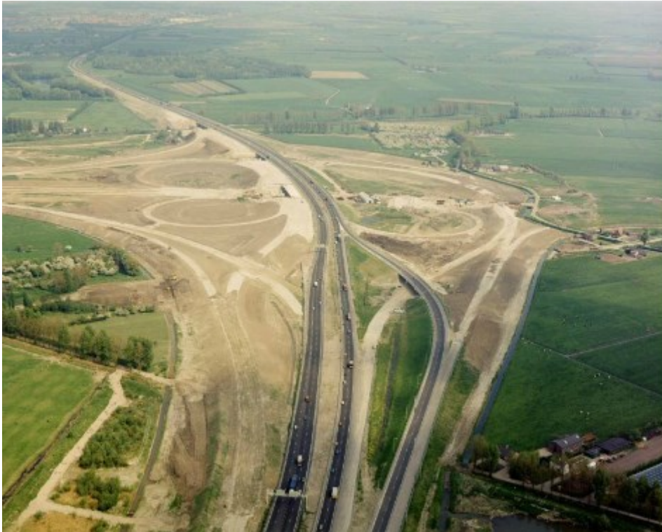
Figuur 4.11: Luchtfoto uit 1978 van rijksweg 12 (A12) te Utrecht met aanleg van klaverblad van het knooppunt Lunetten en de A27 (bron: Het Utrechts Archief)
