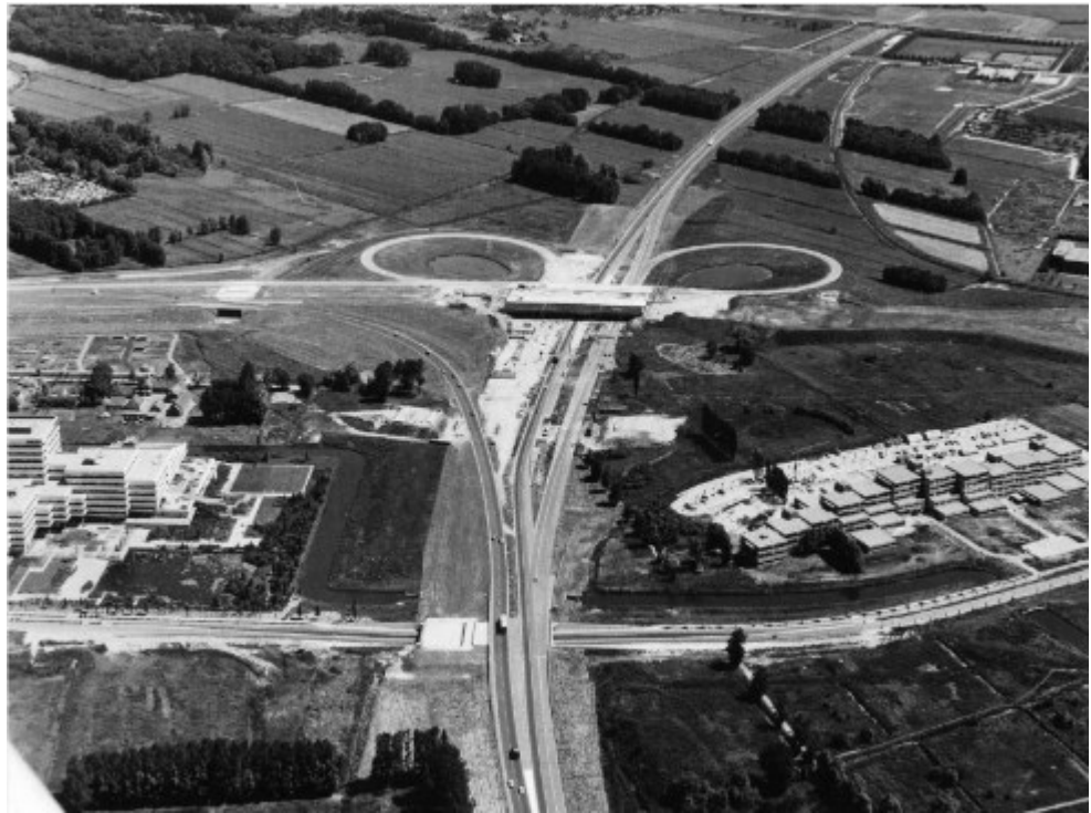
Figuur 4.10: Luchtfoto uit 1976 vanuit westen met de aanleg van knooppunt Rijnsweerd: A28 vanaf onder naar rechtsboven en kruisend het tracé voor de A27 (bron: Het Utrechts Archief)
