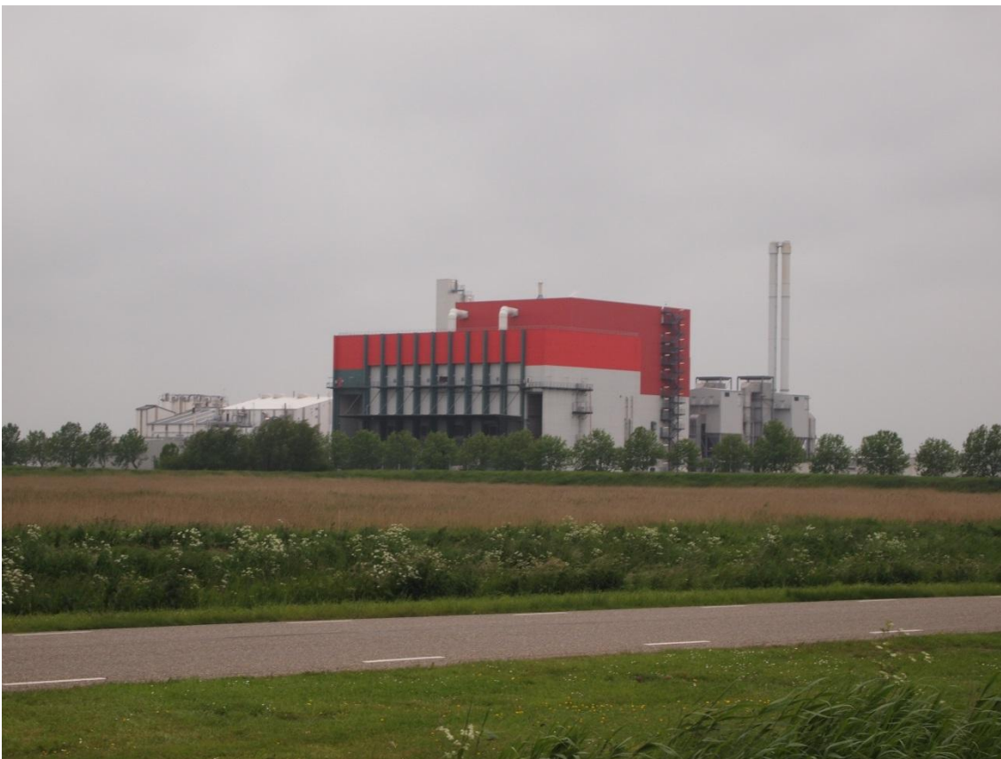
Afbeelding 1 Het huidige noordoostaanzicht van de installatie van EEW. Dit aanzicht kijkt op de bunker, met daarachter de eerste twee lijnen (afvalverbranding, rookgasreiniging en schoorsteen) (Bron: foto uit eigen bestand)
