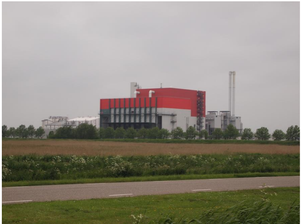
Figuur 1. Het huidige noordoostaanzicht van de installatie van EEW. Dit aanzicht kijkt op de bunker, met daarachter de eerste twee lijnen (afvalverbranding, rookgasreiniging, en schoorsteen) (Bron: foto uit eigen bestand)
