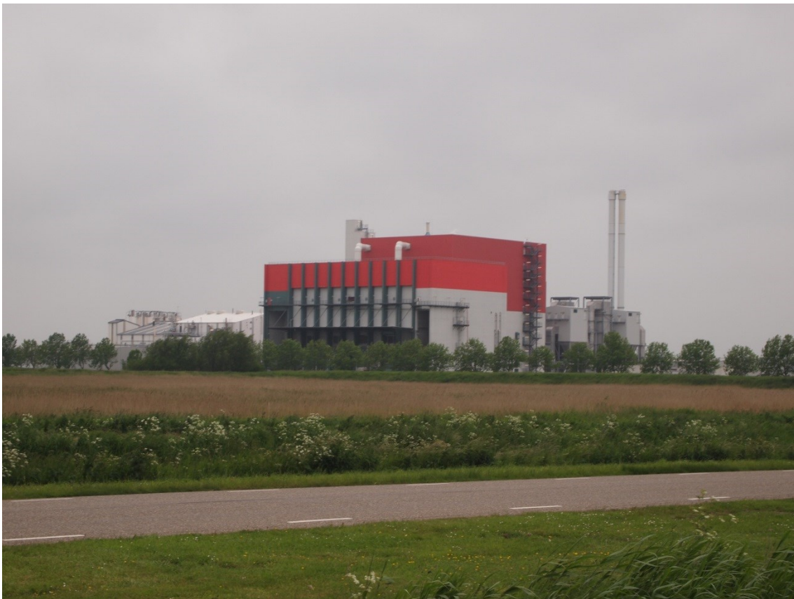
Figuur 1 Het huidige noordoostaanzicht van de installatie van EEW. Dit aanzicht kijkt op de bunker, met daarachter de eerste twee lijnen (afvalverbranding, rookgasreiniging en schoorsteen) (Bron: foto uit eigen bestand).
