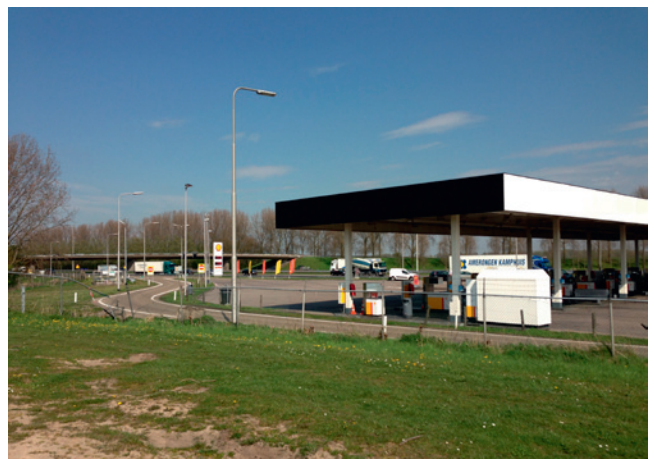
Tankstation en viaduct A16
