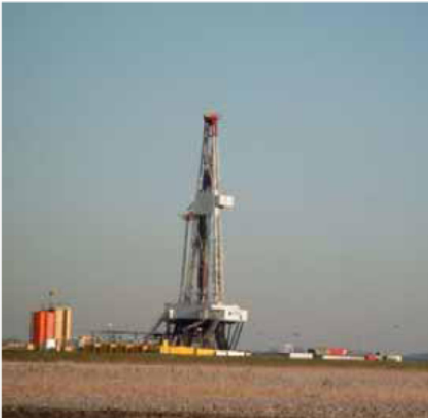
Afbeelding 5 Voorbeeld van een boorinstallatie
