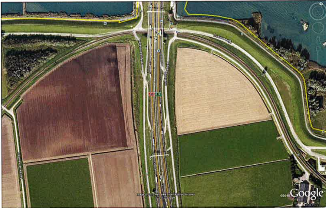
Figuur 9 Zuidzijde van de brug over het Hollandsch Diep
