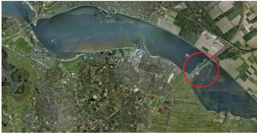
Ligging plangebied in regionaal verband (boven) en luchtfoto Voorland Stichtsebrug (onder)
