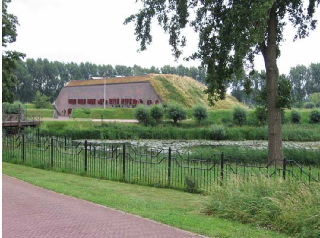
Figuur 15.2 Fort Steurgat
