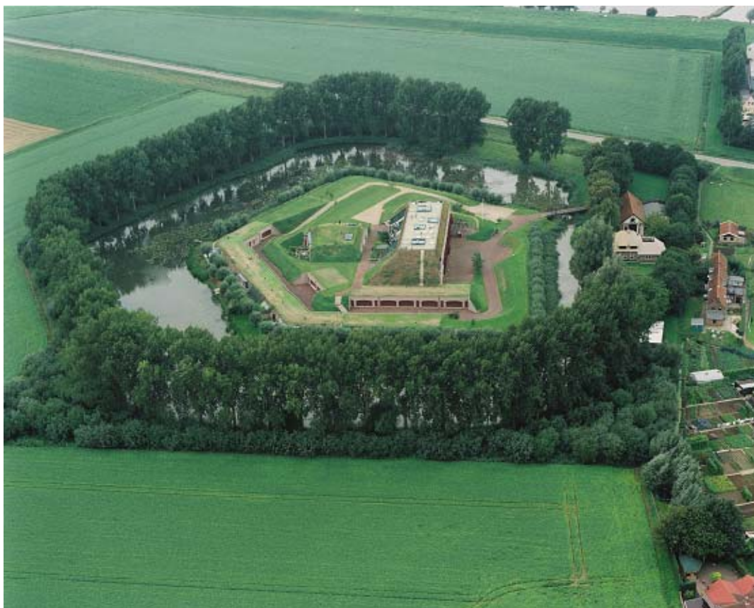
Figuur 5.11 Fort Steurgat
