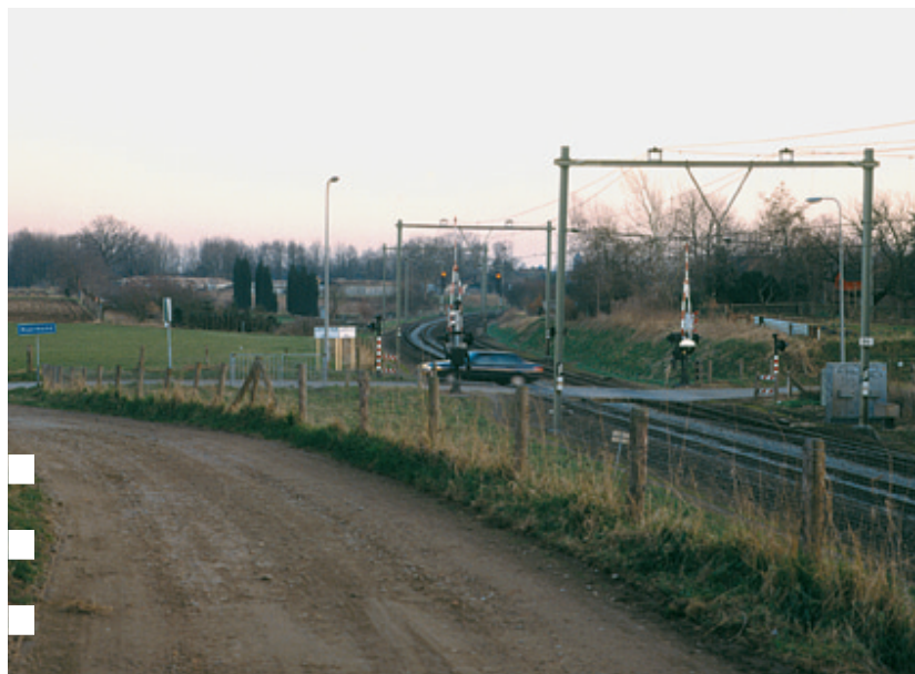
Baanvak Weert-Roermond ter hoogte van de uittakking van alternatief A3, gezien in oostelijke richting
