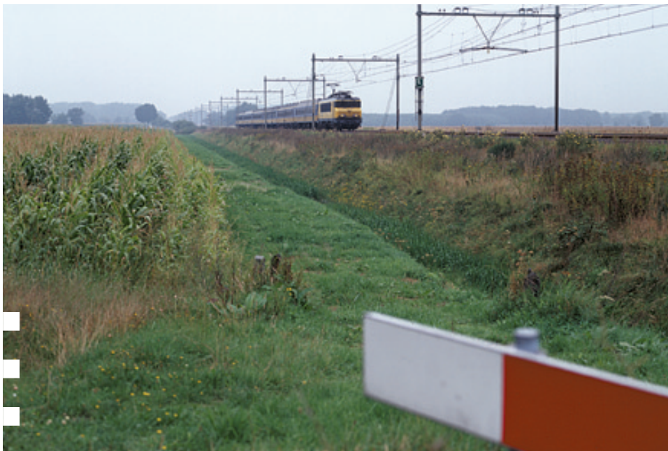
Intakkingspunt van de kleine boog bij Weert op het baanvak Weert-Eindhoven
