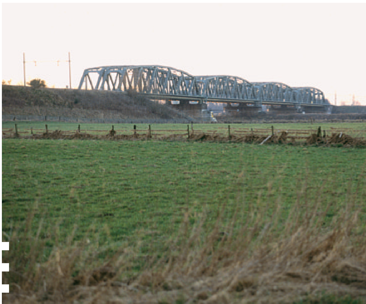
Spoorbrug over de Maas in het historisch tracé bij Roermond, gezien in westelijke richting
