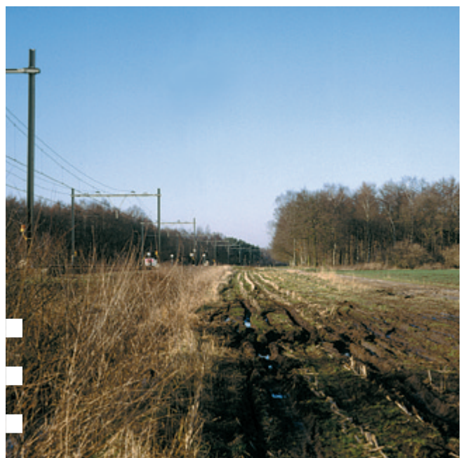
Aftakkingspunt van de grote boog bij Eindhoven ten noorden van Heeze, gezien in de richting van Eindhoven
